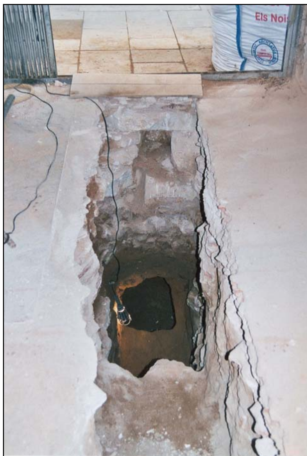
F3: Vista del tram de façana de la rasa 1.
