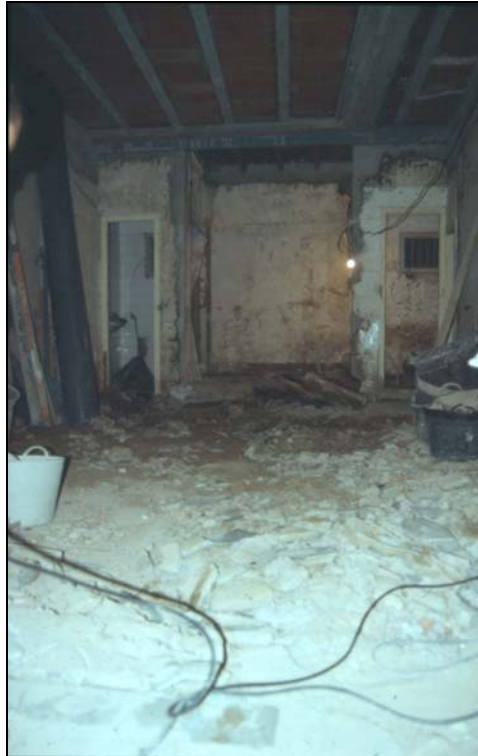
F1: Vista general de la finca durant la intervenció.
