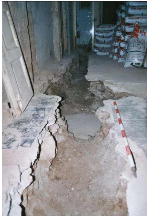
F2: Vista general del tram nord de la rasa 1
